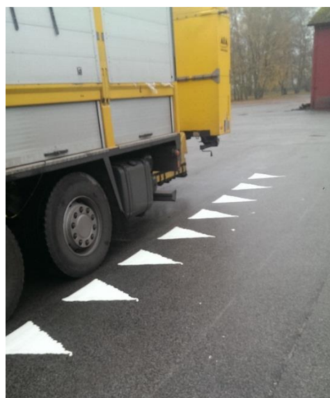
Bild 7, Maskinell vägmarkering av symboler kompatibel med GPS-indata
